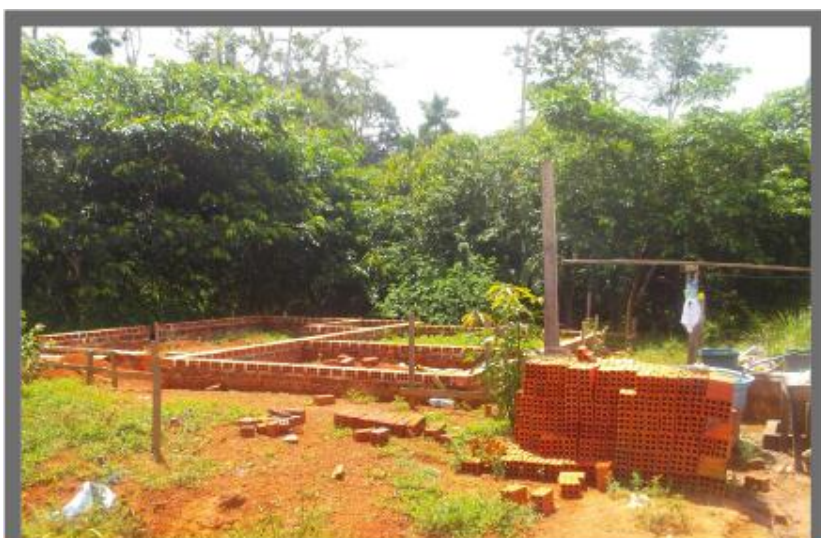
Casa en construcción en el área urbana
