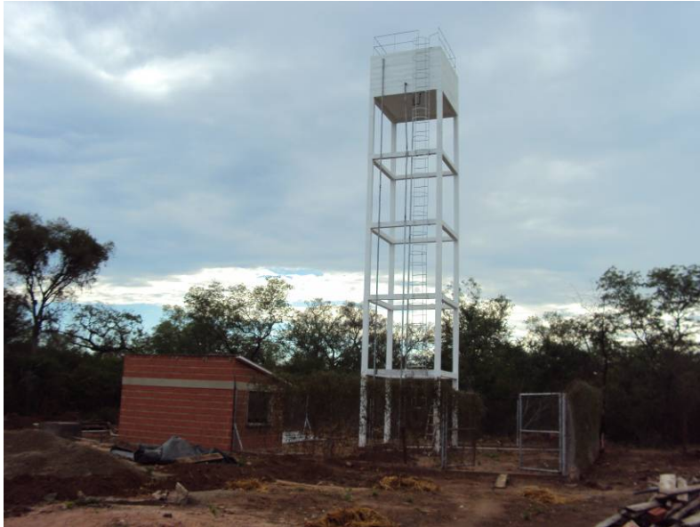
Perforación de pozos profundos en la llanura chaqueña (Yembiaguasu)
