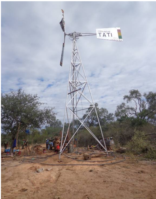
Perforación de pozos profundos y extracción del agua con bomba eólica (Yembiaguasu)
