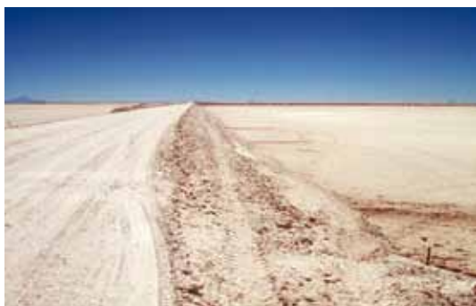
Uyuni-litio, terraplén elevado y grandes piscinas de evaporación de salmueras. Foto M.Ribera
