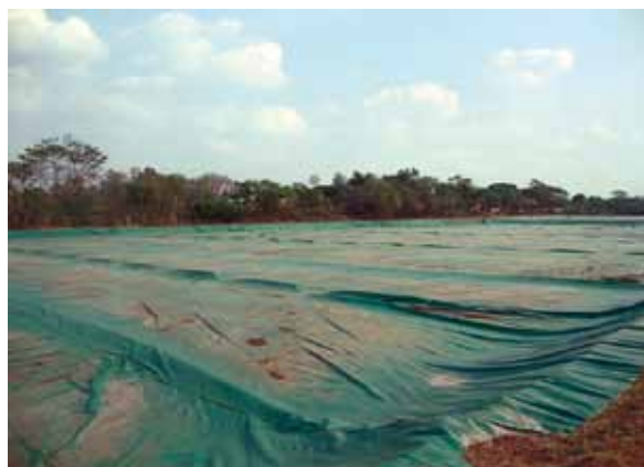
PTAR de SAGUAPAC: captura de metano. Foto GTZ/ PROAPAC
